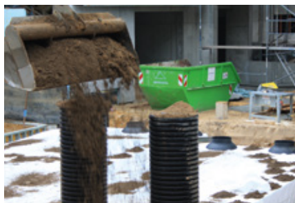
Functie afdekking voor de bouwphase bij opvullen
